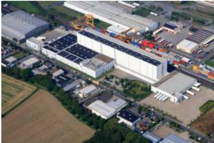
Bönen LZS – Siemensstraße 1
